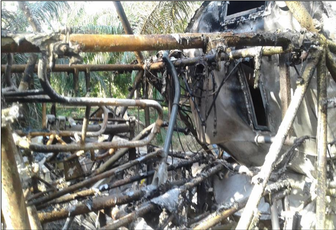
Fotografía No. 3: Condición de la cabina
